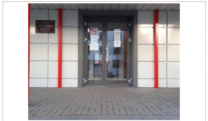
Фото 2.3 – Входная площадка перед дверью
