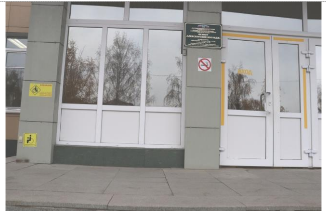
Фото №12 – Входная площадка (перед дверью)
