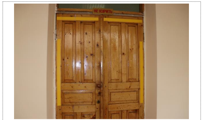
Фото №8 – Дверь внутри здания
