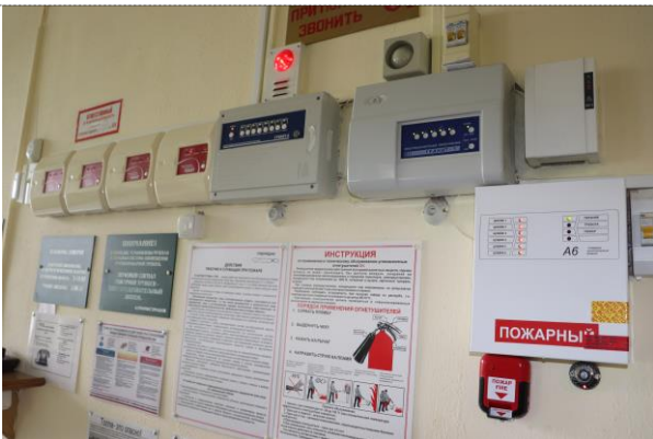
Фото №21 – Акустическая система оповещения
