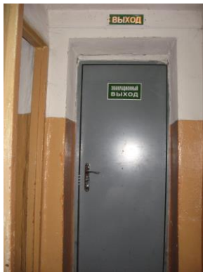
Фото №13 – Пути эвакуации
